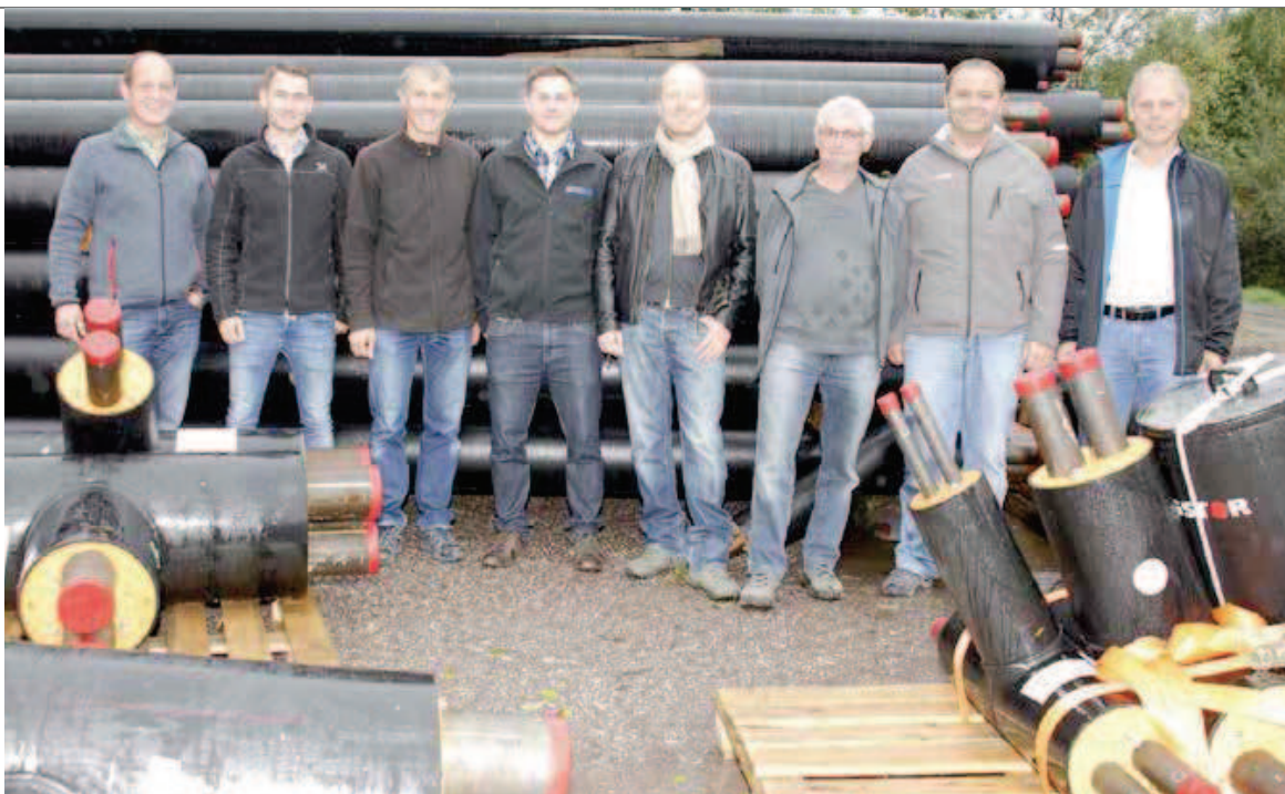
Jetzt gehts los: Die drei Bauherren (rechts im Bild) zusammen mit den Planern beim Spatenstich der neuen Holzschnitzelfeuerungsanlage im Seezdelta in Walenstadt.
